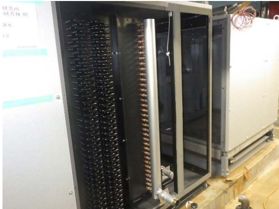
写真 2.1.12-1 給気第1・2系統空調機コイルセクション他更新後
