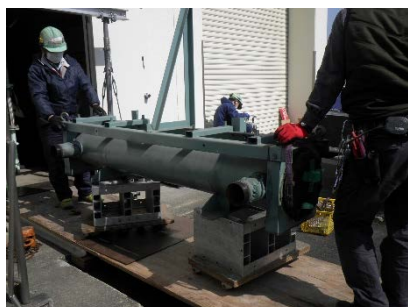
既設蒸発器撤去
