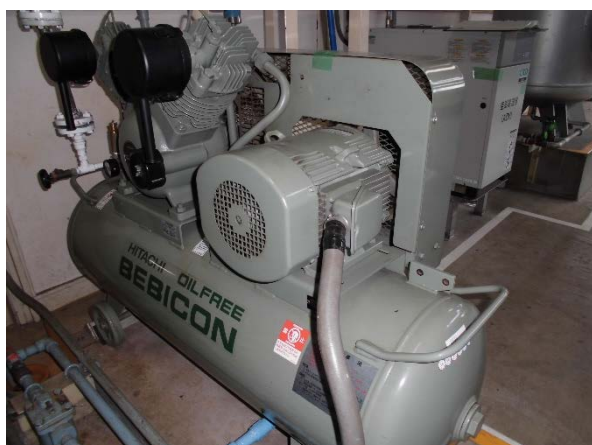
写真 2.1.9-1 空気圧縮機No.1 と交換した圧力調整弁
