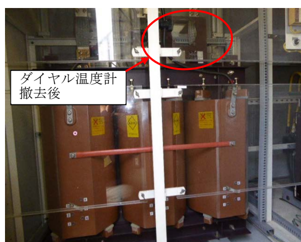
写真 2.1.2-2 三相変圧器ダイヤル温度計撤去後
