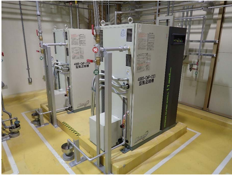
写真 2. 1. 21-1 更新した 3NBT 棟空気圧縮機
