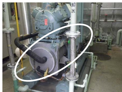
新設蒸発器設置
