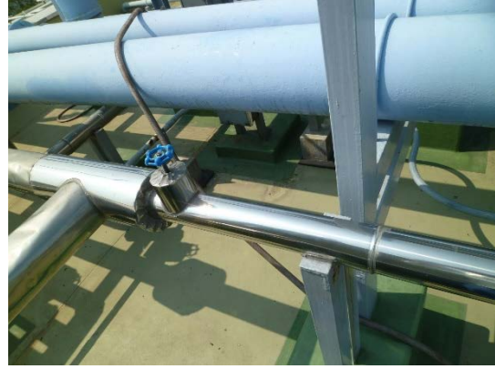
補給水配管更新後
