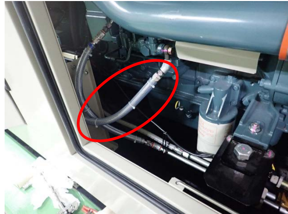
写真 2.1.16-2 燃料フレキ管交換後
