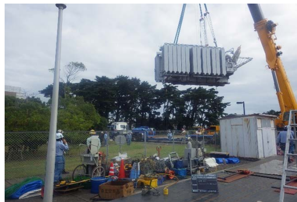
変圧器搬出状況
