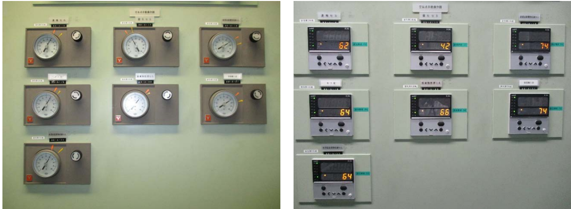
写真 2.1.7-3 給気バタフライ弁用手動設定器 (左) 更新前、(右) 更新後
