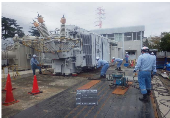
変圧器撤去状況
