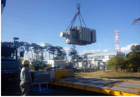
変圧器搬入状況
