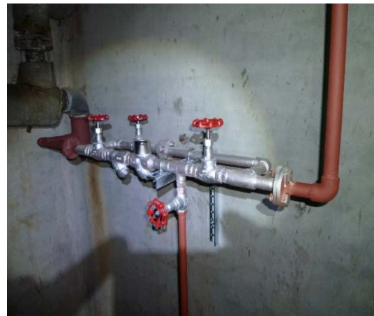
写真 2.1.14-2 蒸気配管一式補修後
