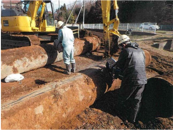
写真 2.8.5-1 導水管撤去状況
