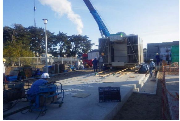
変圧器据付状況
