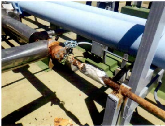
補給水配管更新前
