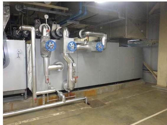
写真 2.1.12-1 給気第1・2系統空調機コイルセクション他更新後
