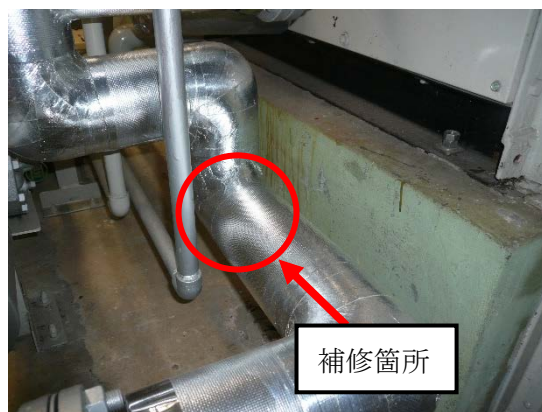
写真 2.1.18-2 機械室蒸気管（補修後）
